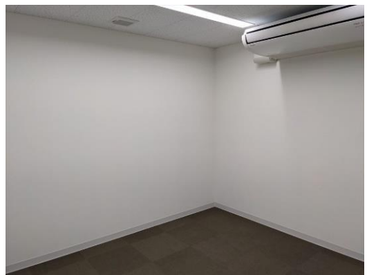
サーバールーム
